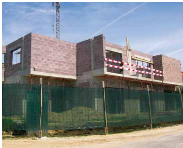
Obra com Bloco Térmico® e Isolsónico®
